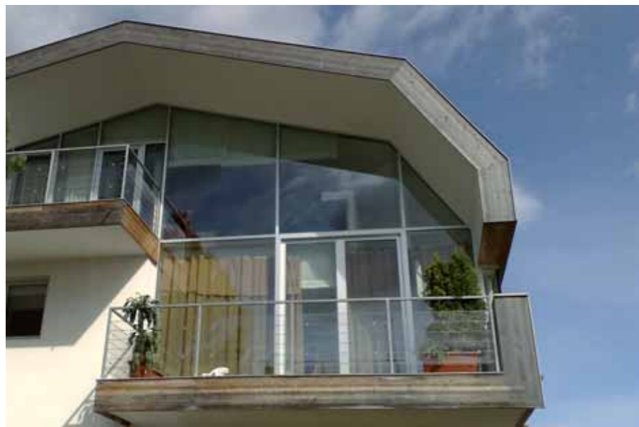
Moderne Fensterstechnik reduziert die Profilansicht und erhöht die Glasfläche. Tecnologia moderna per ridurre i profili a favore della superficie vetrata.
