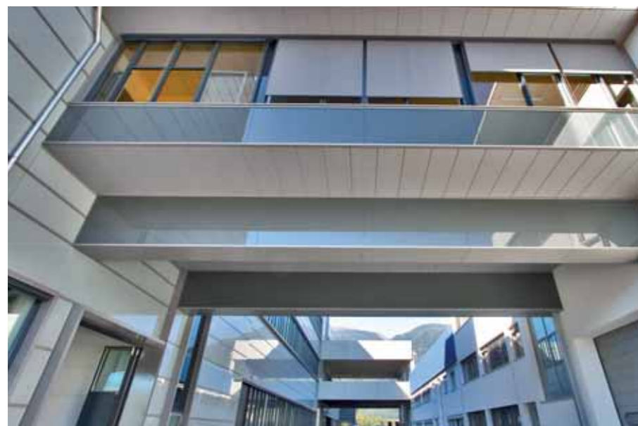
Aluminium und Glasemaille als hochwertige Designerelemente bei der Verkleidung von Fassaden. Alluminio e vetro smaltato sono pregevoli elementi di design nel rivestimento di facciate.
